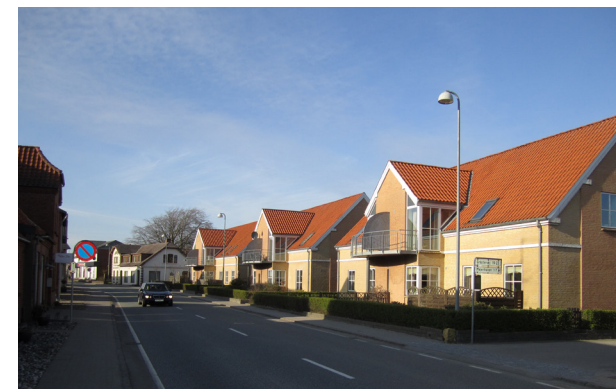
Ny boligbebyggelse på Gråstenvej.
